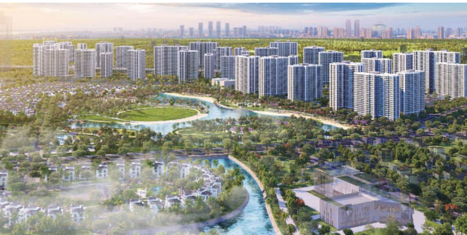
VINHOMES GRAND PARK – TP.HCM – Cung cấp và lắp đặt cửa an toàn căn hộ – Quy mô: 27.180.000 m 2
