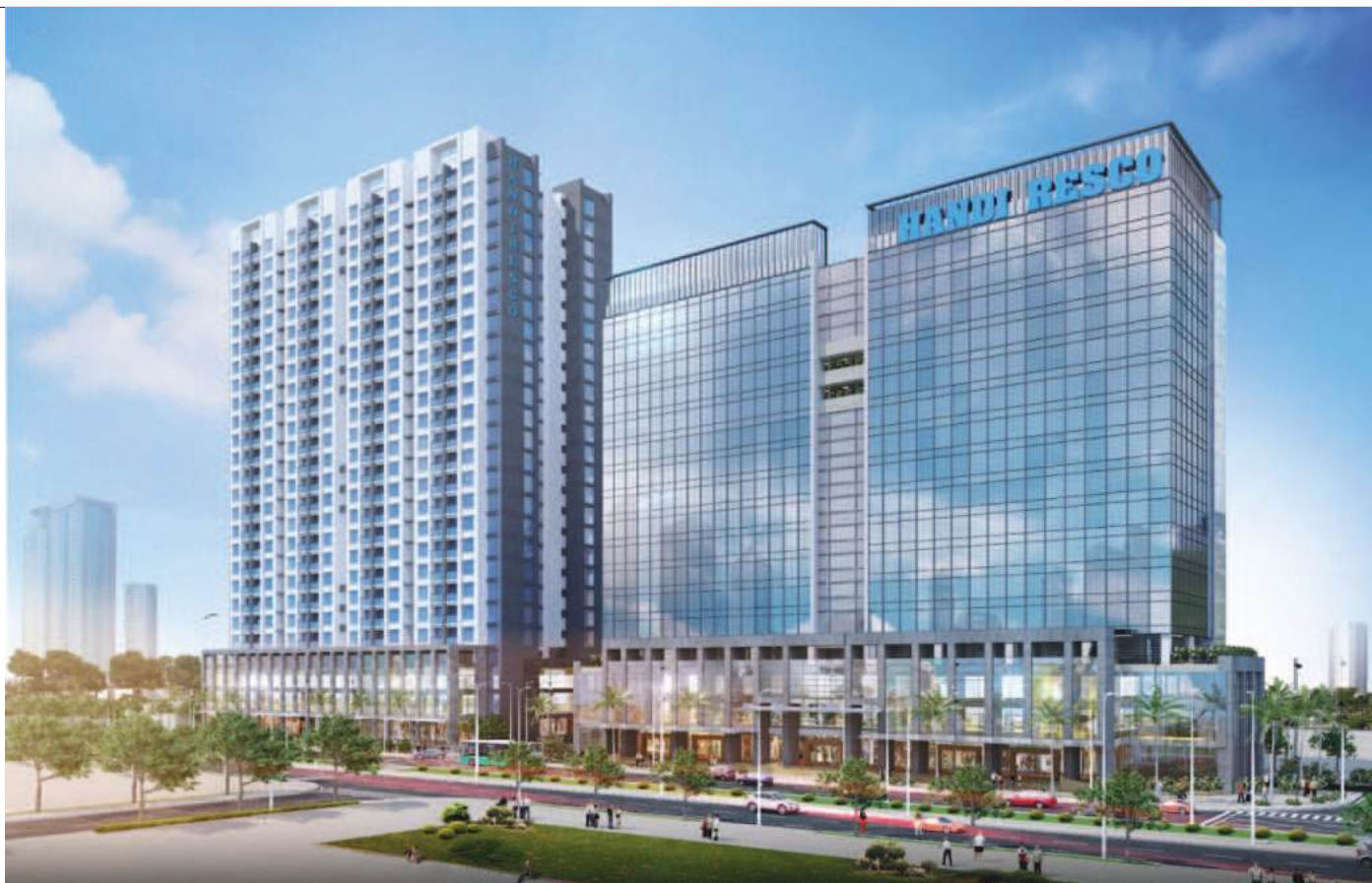
HANDIRESCO TOWER - HÀ NỘI - Cung cấp và lắp đặt cửa ABS thông phòng, cửa chống cháy Quy mô: 2.410 m 2
