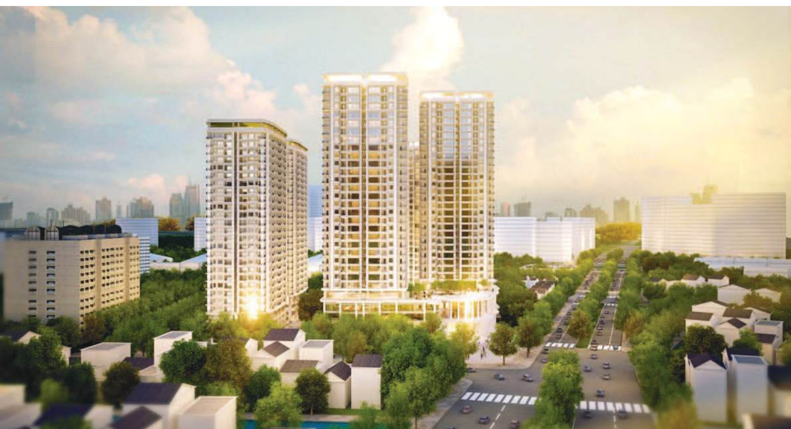
CHUNG CƯ IRIS GARDEN – HÀ NỘI – Cung cấp và lắp đặt cửa thép chống cháy – Quy mô: 22.000 m 2
