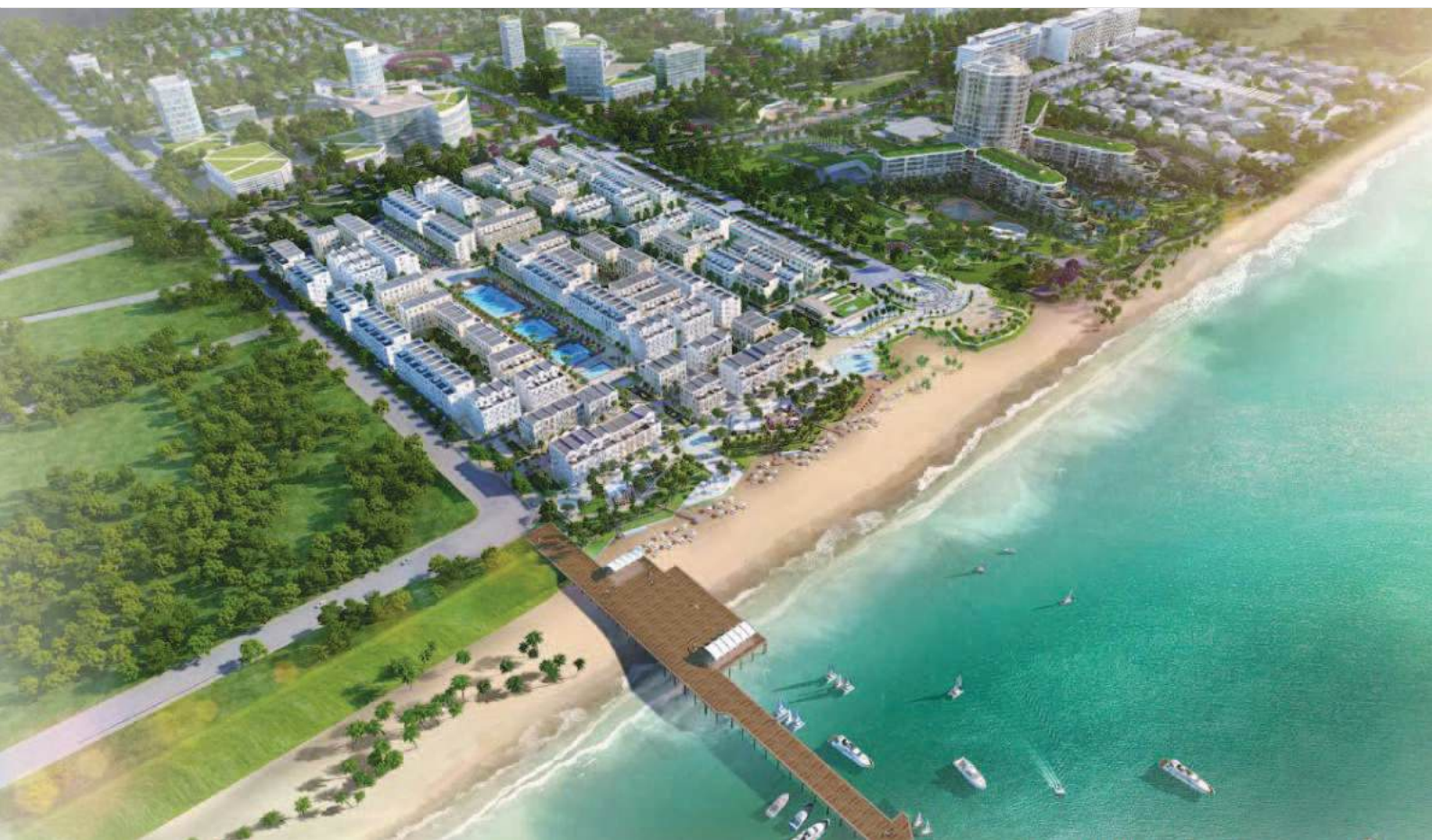
WATERFRONT – PHÚ QUỐC, KIÊN GIANG – Cung Cấp Và Lắp Đặt Cửa Thép Chống Cháy – Quy Mô: 32.000 M2
