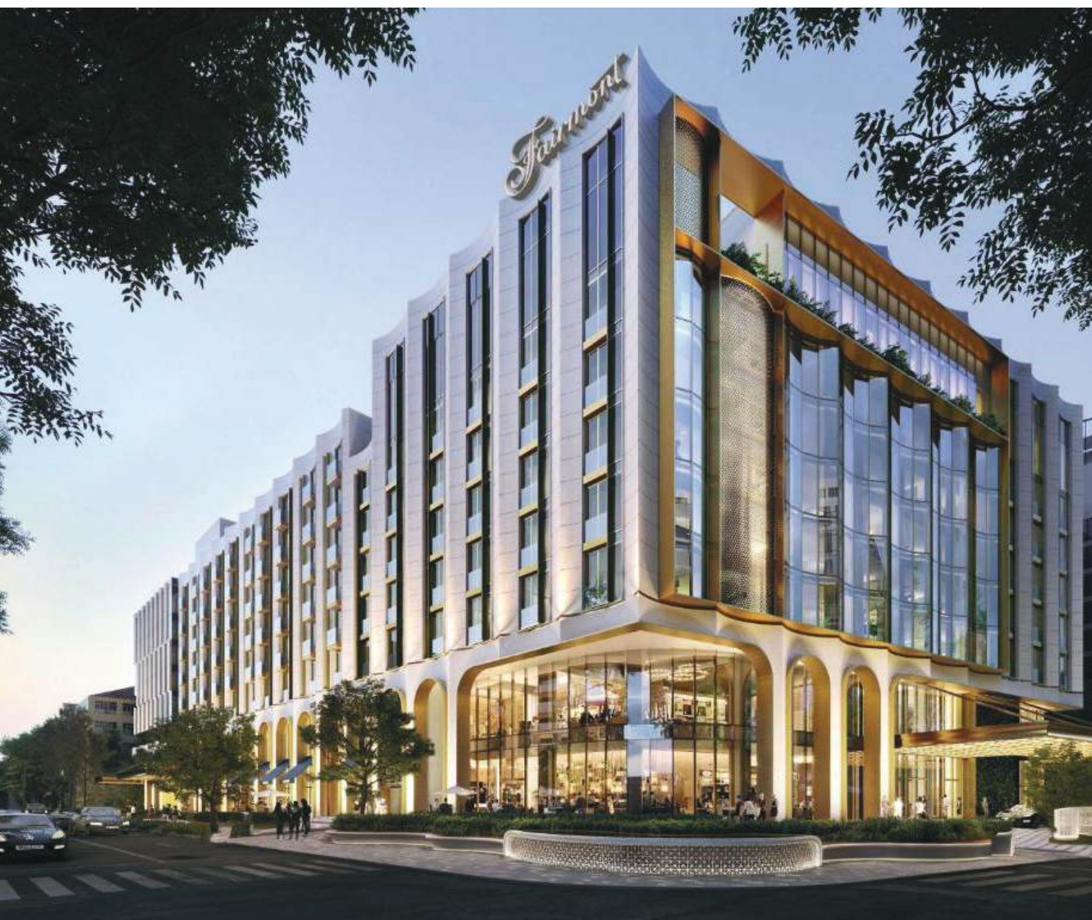
KHÁCH SẠN 6 SAO FAIRMONT – HANOI – TẬP ĐOÀN GELEX “ Cung cấp lắp đặt cửa thép chống cháy”
