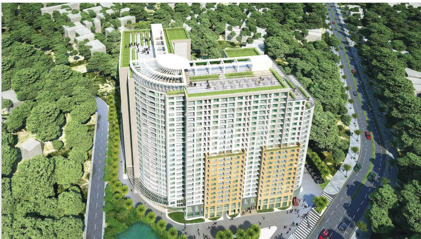
T&T RIVERVIEW - HÀ NỘI - Cung cấp và lắp đặt cửa kính căn hộ, cửa thép chống cháy Quy mô: 8.850m 2
