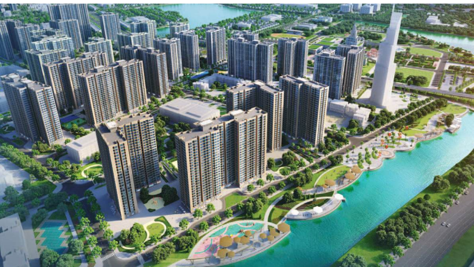
VINCITY OCEAN PARK – HÀ NỘI – Cung cấp và lắp đặt cửa thép chống cháy – Quy mô: 2.800.000m2
